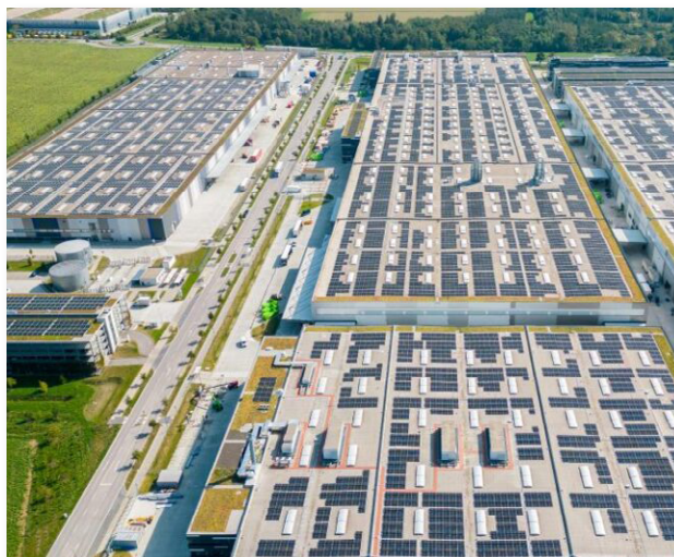
Abbildung 54: Implementierung von Photovoltaik auf den Dachflächen grosszügiger Industriegebäude
