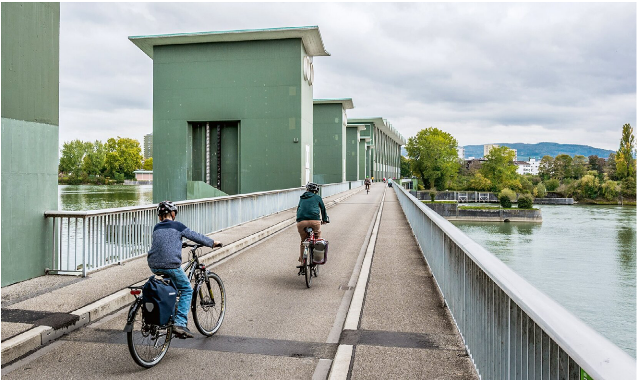
Abbildung 60: Kraftwerkanlage Birsfelden. Quelle: Andreas Zimmermann
